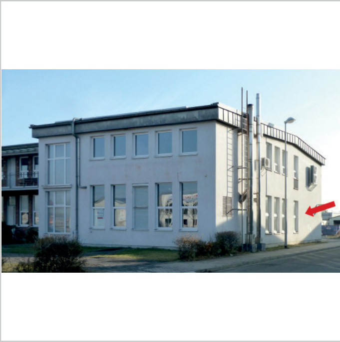
Mietinheit im re. Gebäudeteil
